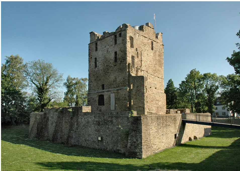
Kernburg der Burg Altendorf – Ansicht von Norden (2007)
