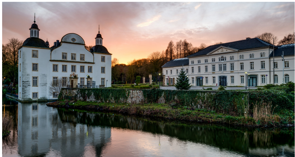
Herrenhaus und Wirtschaftsgebäude – ansicht von Nordosten (2012)
